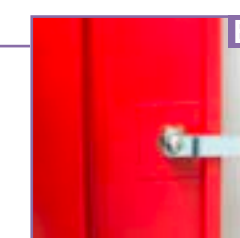
zamek cylindryczny ryglujący drzwi w 1 punkcie (B)
